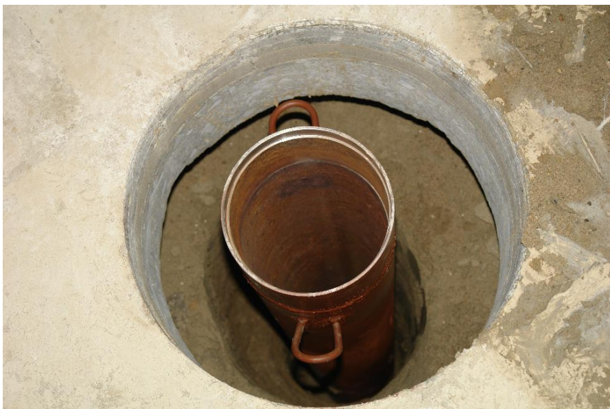
Рис. 10. Фотографии этапа монтажа заглубленного защитного контейнера для выдержки и временного хранения активированных мишеней.
